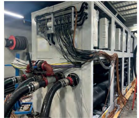
DIE NEUE Wärme-Kälte-Kopplungsanlage (re. i. Bild) am Uniklinikum Graz nutzt die vorhandene Abwärme zur Erzeugung von Kälte und Wärme und hilft damit kostengünstig sowie umweltfreundlich den steigenden Energiebedarf zu decken. Dieses innovative Projekt wurde vom Österreichischen Verband Grüner Krankenhäuser (ÖVGK) mit dem Innovations- und Nachhaltigkeitspreis 2025 ausgezeichnet.
